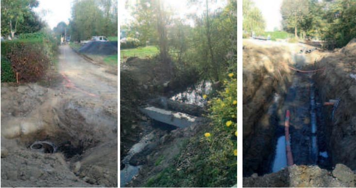
Après contrôle des canalisations à l'aide d'une caméra, il s'est avéré que la canalisation principale qui longe la Moselle et qui date de la création de la station était en très mauvais état : affaissement et fuites aux jonctions des canalisations.
