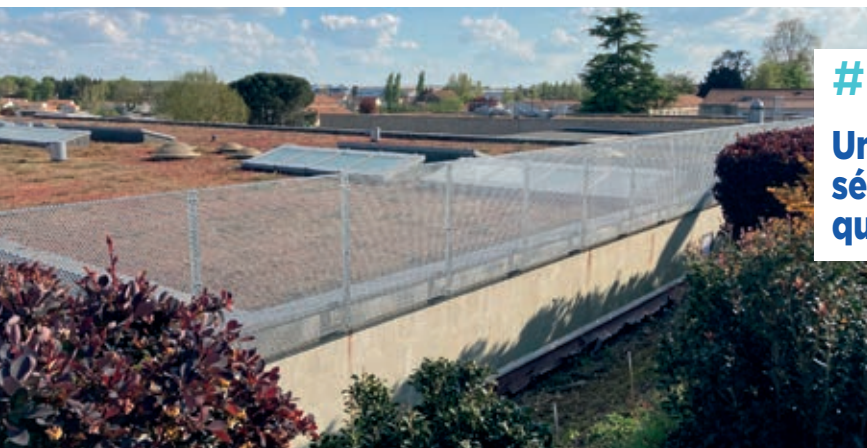
Sécurisation des toits du restaurant scolaire & école pour éviter les intrusions.
